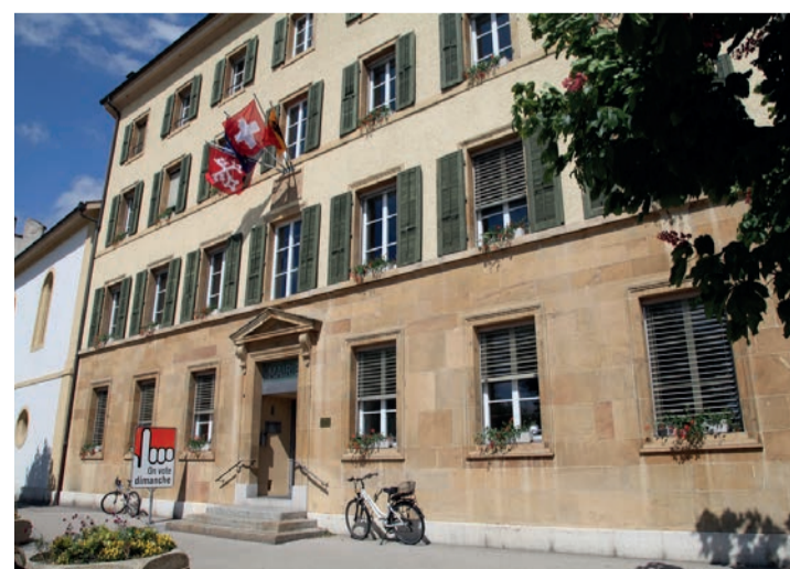
La Mairie de La Neuveville, un bâtiment très convoité.
